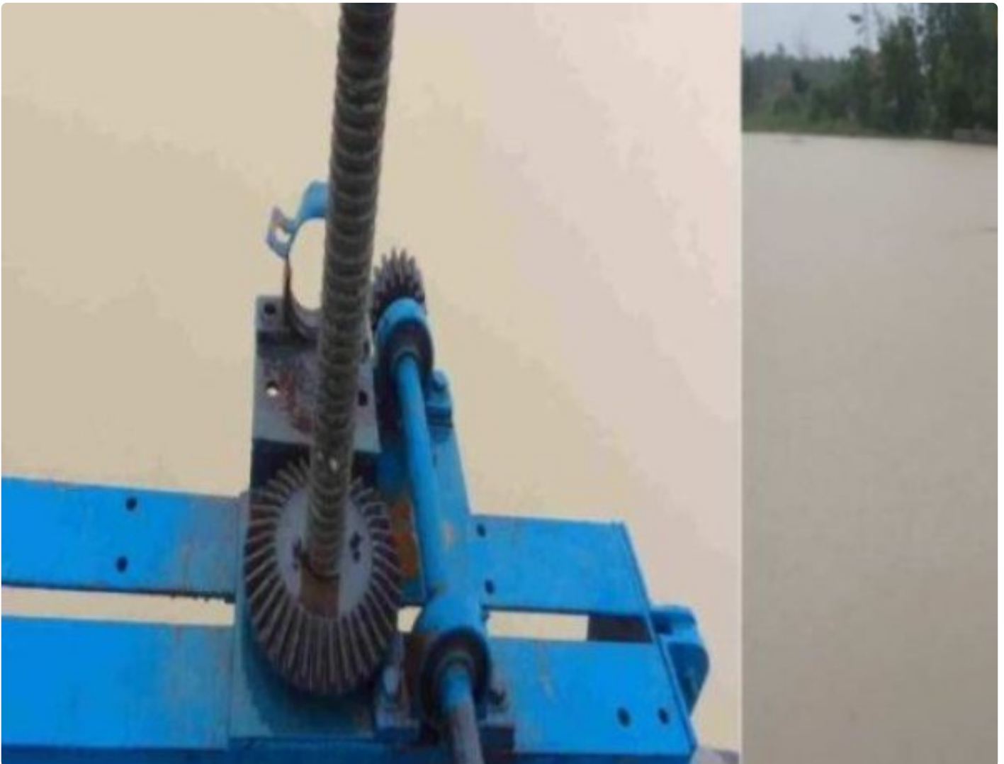
Pintu air Albaret Simpang Mesuji
