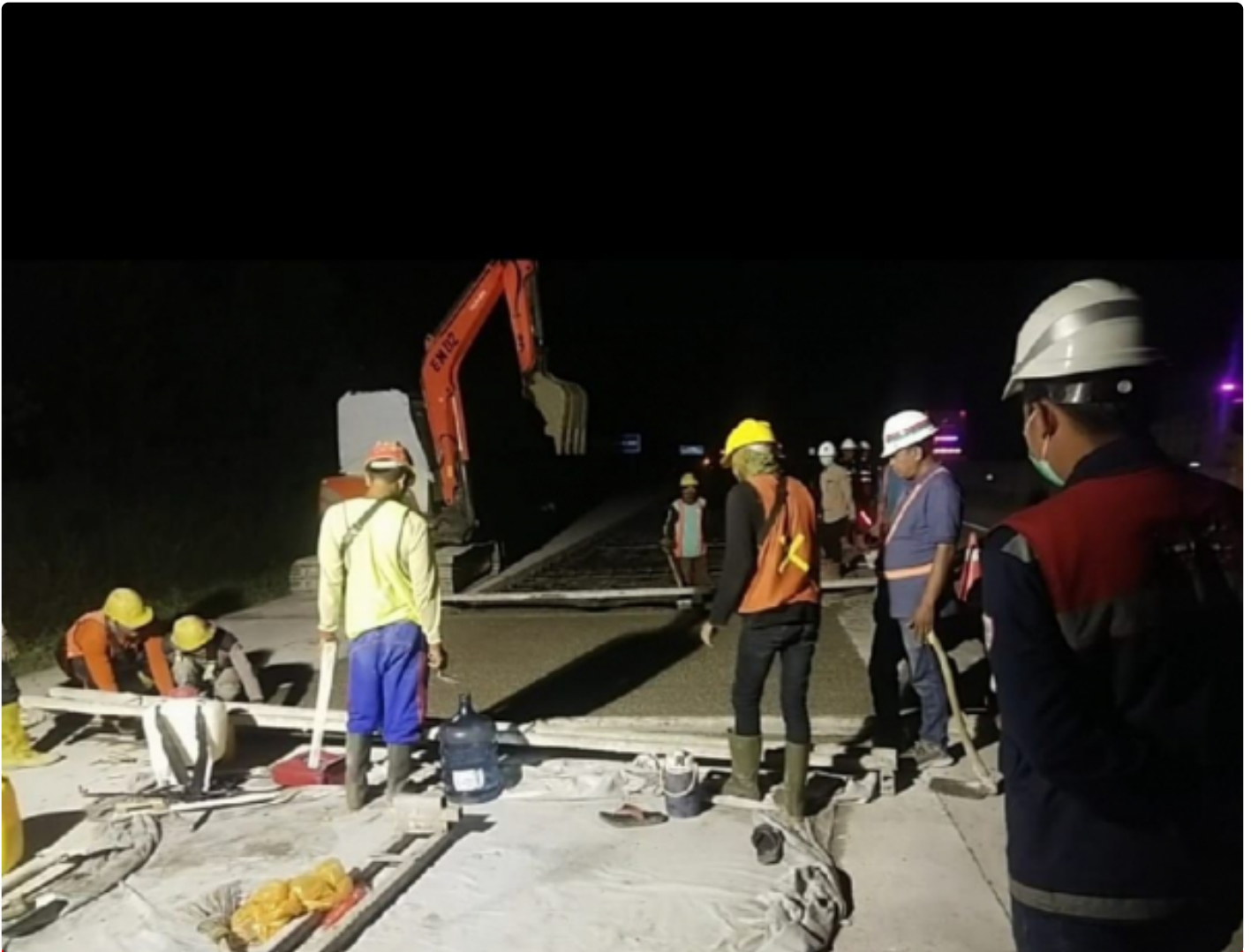
PT HKI Perbaikan Tol Terbanggi Kayu Agung
